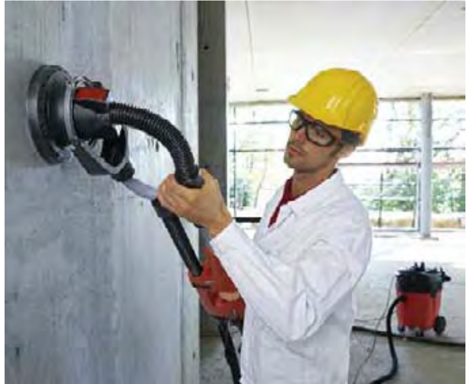
Mühelos entfernt die WST 1000 FV Stoßfugen und Betongrate. Und für eine saubere Arbeitsstelle und gesunde Raumluft sorgt die integrierte Absaugung mit unseren Industriesaugern S 36, S 47 und S 47 M.
